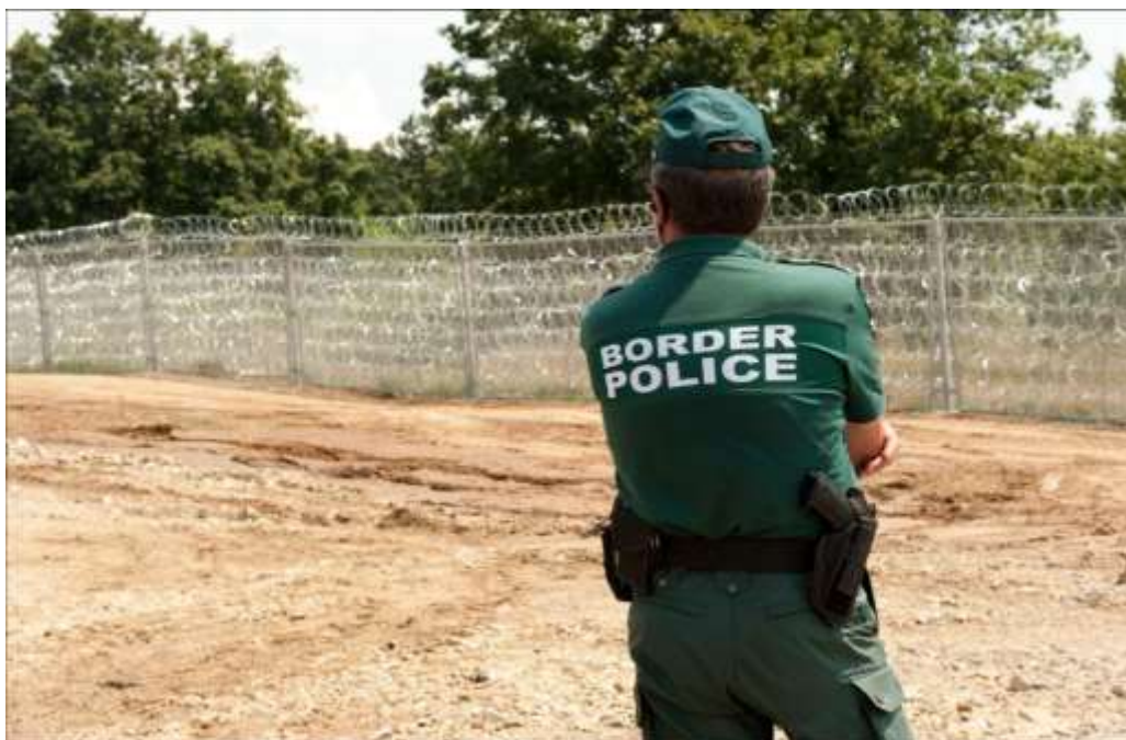
Prima fase di costruzione della “barriera tecnica” al confine Bulgaria-Turchia – F.Martino/OBCT
